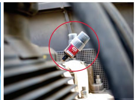
Bearing lubrication on a fan
